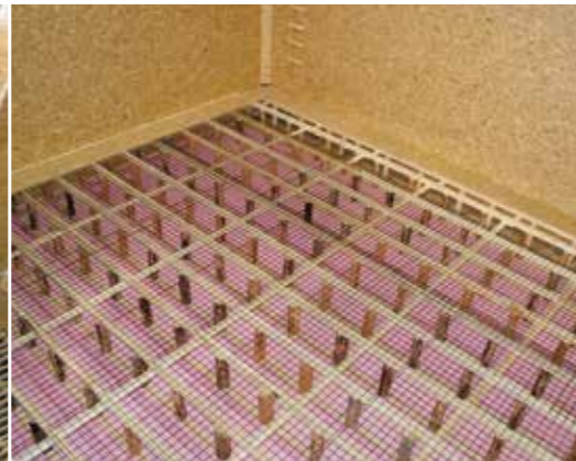
Baustahlgitterrost mit Fußbodenisolierung
