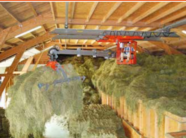
Zum Befüllen und Entleeren der Trocknungsbox sind Auer Krananlagen unentbehrliche Helfer
